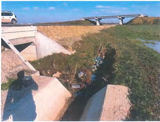
Fig. 6.5.22-2 - Capăt podeț aval
