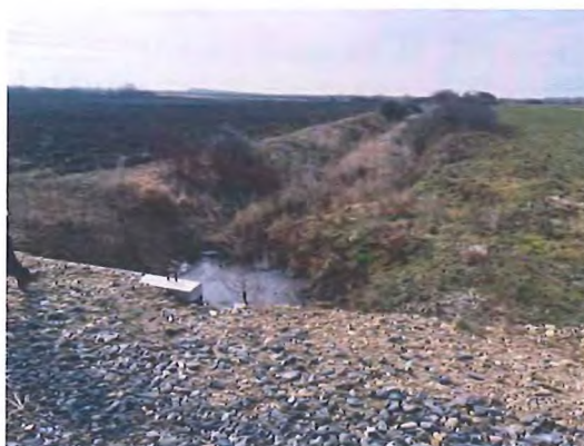
Fig. 6.5.13-4 - Vedere canal amonte
