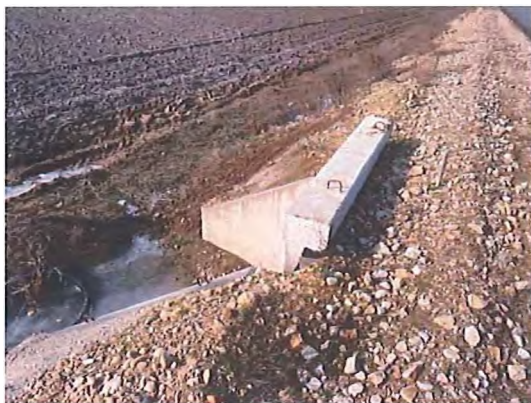
Fig. 6.5.13-5 - Capăt podeț aval
