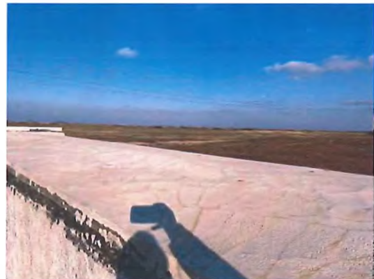
Fig. 6.5.25-5 - Protecție hidroizolație mortar M100
