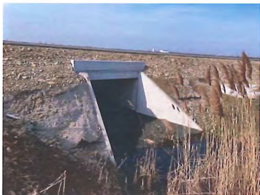
Fig. 6.5.8-2 - Capăt podeț aval
