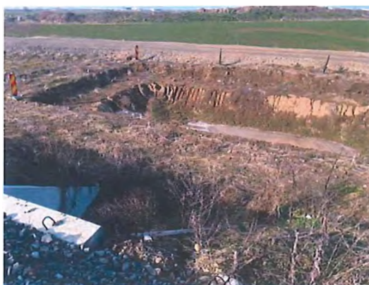
Fig. 6.5.17-6 – Săpătură bazin de retenție
