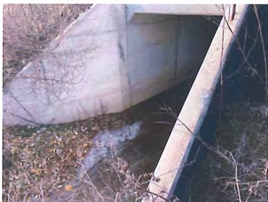
Fig. 6.5.12-2 - Capăt podeț aval
