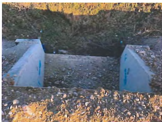
Fig. 6.5.27-3 - Capăt podeț aval
