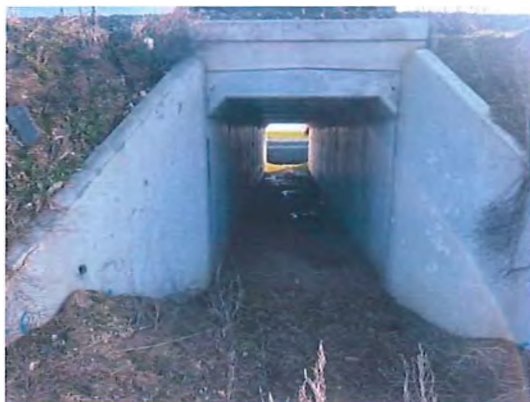
Fig. 6.5.17-4 - Capăt podeț aval
