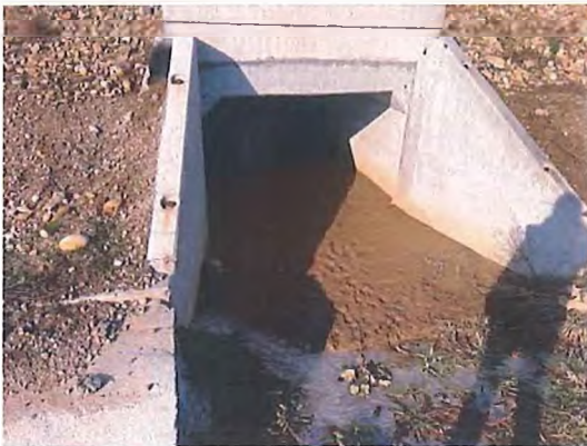
Fig. 6.5.20-2 - Capăt podeț aval
