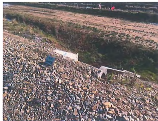
Fig. 6.5.23-6 - Capăt podeț aval
