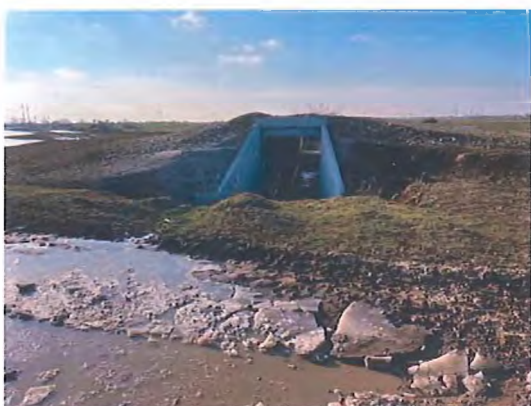
Fig. 6.5.25-10 - Capăt podeț aval
