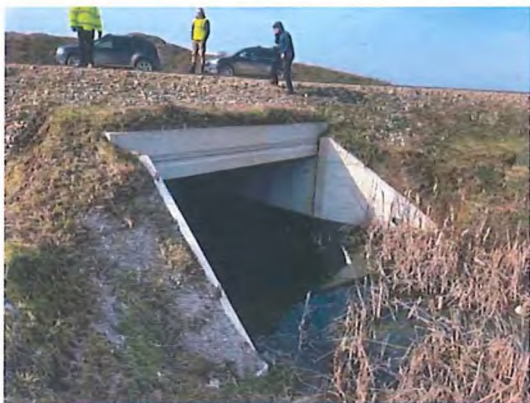
Fig. 6.5.9-2 - Capăt podeț aval
