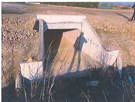
Fig. 6.5.24-4 - Capăt podeț aval
