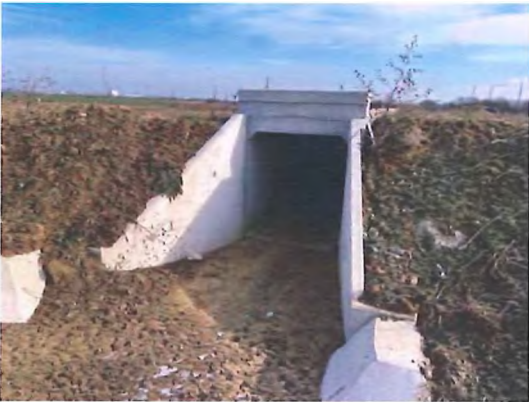
Fig. 6.5.7-4 - Capăt podeț aval
