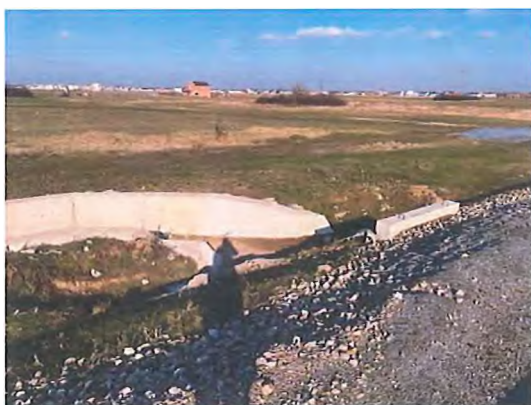
Fig. 6.5.23-2 - Capăt podeț aval
