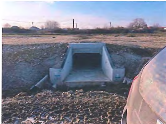
Fig. 6.5.27-8 - Capăt podeț aval
