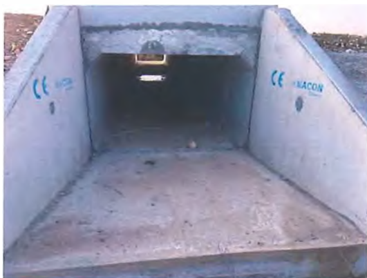
Fig. 6.5.27-6 - Capăt podeț aval
