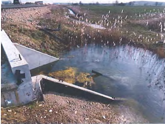
Fig. 6.5.14-2 - Capăt podeț aval
