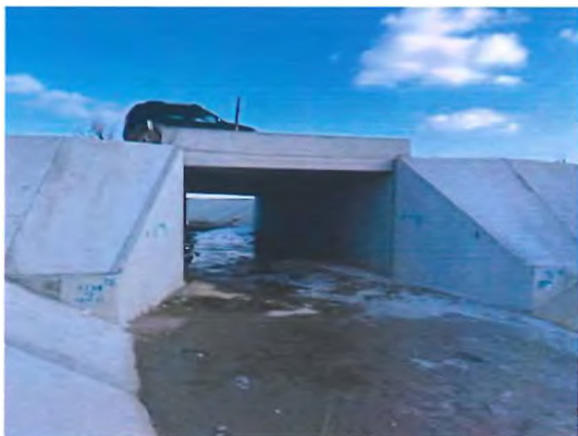
Fig. 6.5.25-6 - Capăt podeț aval
