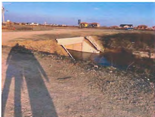
Fig. 6.5.27-12 - Capăt podeț aval
