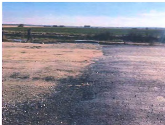
Fig. 6.5.24-6 - Vedere spre canalul de irigații
