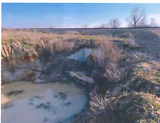
Fig. 6.5.24-3 - Capăt podeț extindere subtraversare existentă
