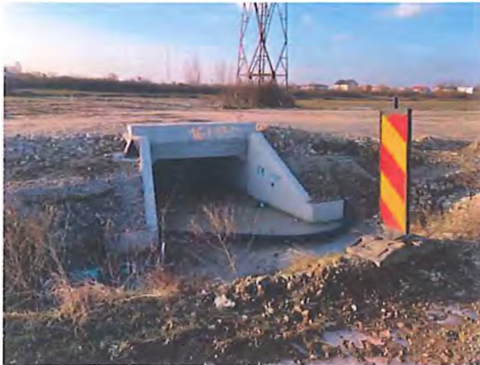
Fig. 6.5.27-10 - Capăt podeț aval
