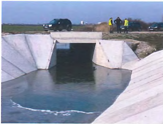
Fig. 6.5.11-2- Capăt podeț aval
