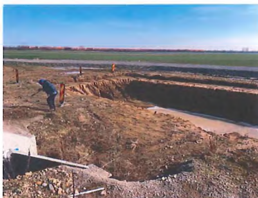
Fig. 6.5.18-5 - Săpătură bazin de retenție
