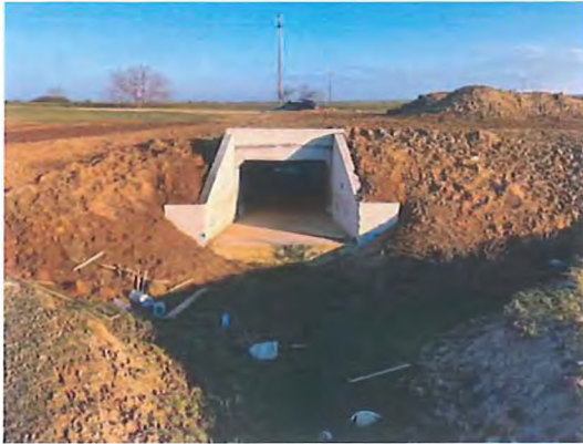
Fig. 6.5.26-2 - Capăt podeț aval
