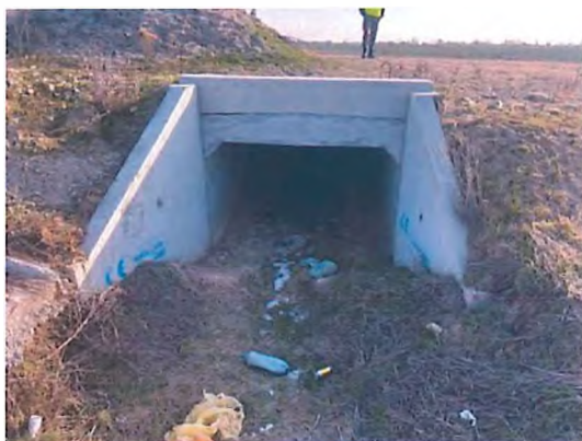
Fig. 6.5.19-2 - Capăt podeț aval
