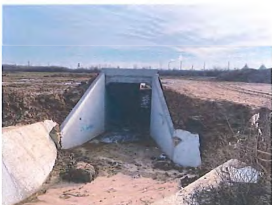
Fig. 6.5.4-4 - Capăt podeț aval
