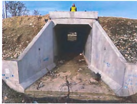
Fig. 6.5.6-3 - Capăt podeț aval
