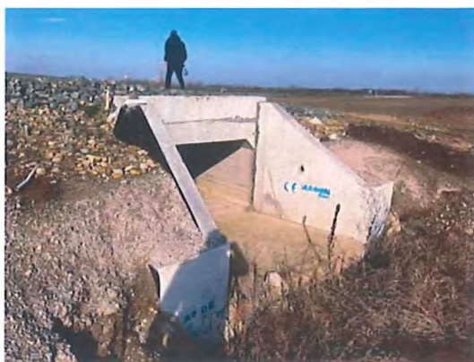
Fig. 6.5.18-2 - Capăt podeț aval
