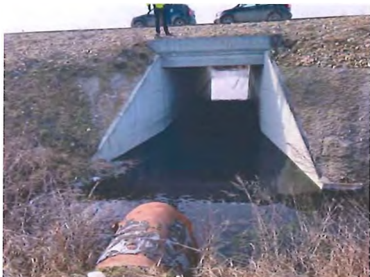
Fig. 6.5.13-2 - Capăt podeț aval
