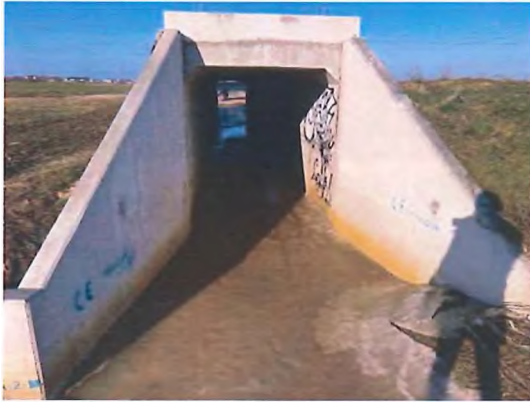
Fig. 6.5.25-2 - Capăt podeț aval
