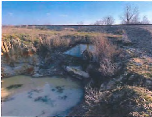
Fig. 6.5.23-8 - Capăt podeț extindere subtraversare existentă
