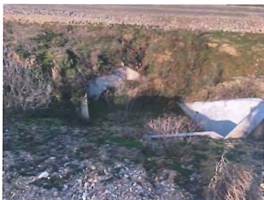
Fig. 6.5.17-2 - Capăt podeț aval
