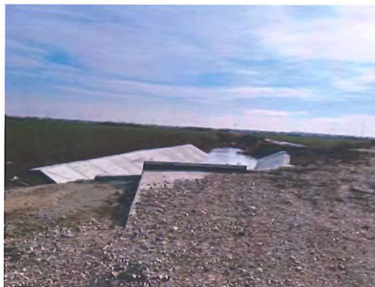
Fig. 6.5.11-4 - Vedere canal existent amonte
