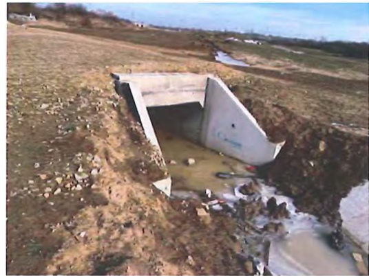
Fig. 6.5.5-3 - Capăt podeț aval
