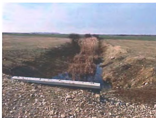
Fig. 6.5.8-4 - Vedere canal amonte
